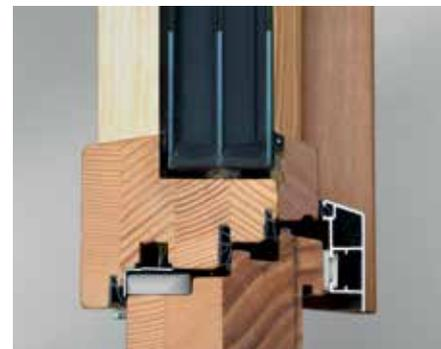
OPTIWIN: innovative Konstruktionen mit zweischaligem Aufbau.
